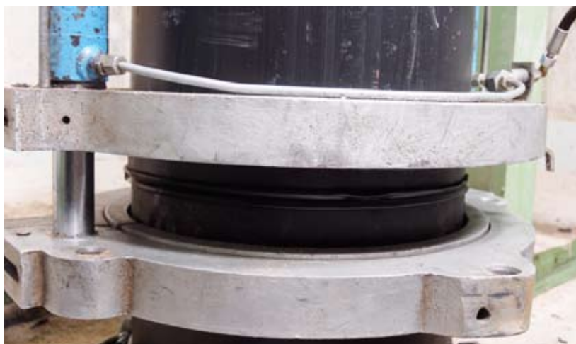
Schweißnaht an der Übergangsstelle
