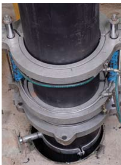
Einbau des neuen Erdschutzrohres
