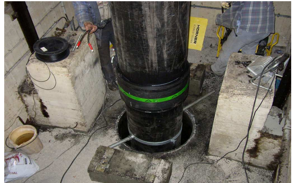
Einbau des Schutzrohrs
