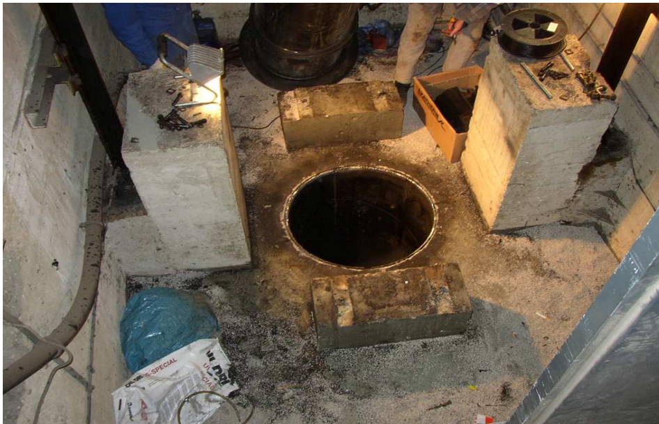
Vorbereitung des Einbaus
