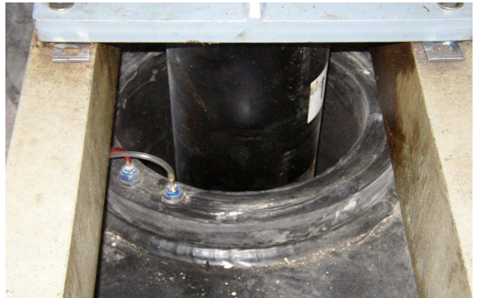
Wiedereinbau des Hydraulikzylinders
